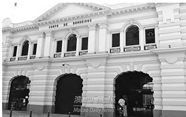
1923 年落成的澳门消防大楼上至今只有葡文的“消防局”字样
